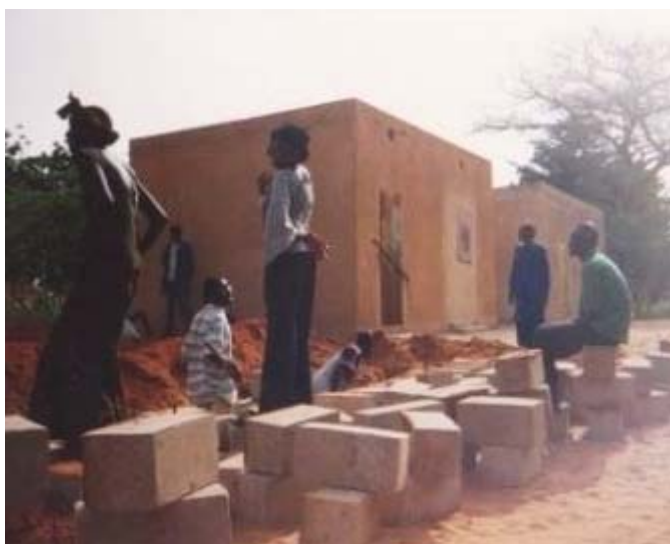
Le chantier de construction de l'école de Maradi.
