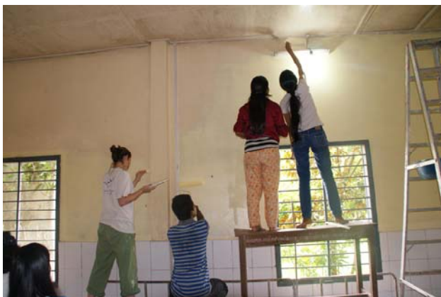
Travaux de réfection de l'orphelinat
